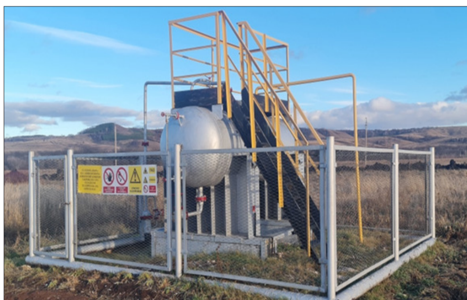
УСК — важный элемент системы газосбора / ФОТО ПРЕДОСТАВЛЕНО ЛЕНИНОГОРСКИМ ГАЗОВЫМ ЦЕХОМ
